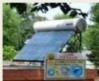
太陽熱温水器 （札幌市次世代エネルギーパーク）
