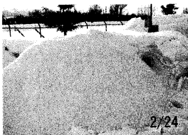
No.1, No.2 消火栓埋設
