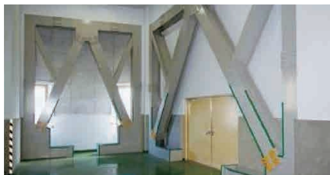
水再生プラザの耐震補強状況
