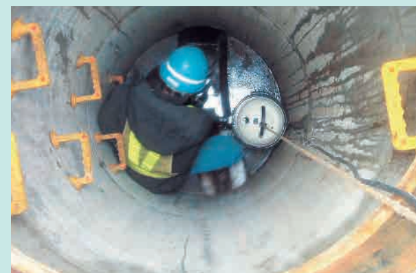
管内清掃作業の様子
