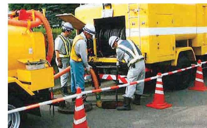
緊急措置訓練（管路清掃）
