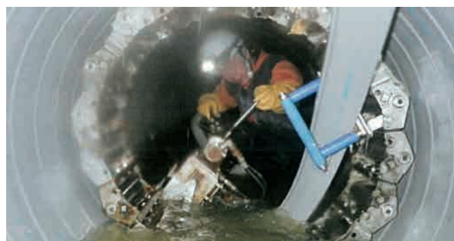
管路の耐震化工事の様子
