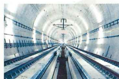
青函トンネル算用師工区 (青森県 / 昭和57年)
