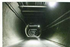
飛騨トンネル避難坑 (岐阜県 / 平成19年)
