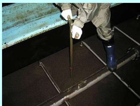
ろ過池調査（調査器具を用いて）
