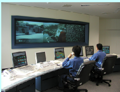
処理状況の監視（浄水場管理室）
