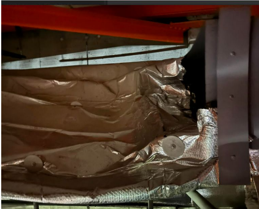
写真2 現況図(空調機側接続部)
