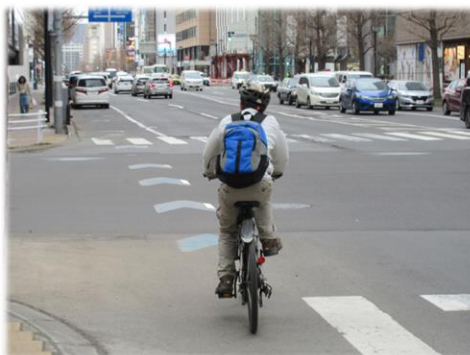
【写真】矢羽根型路面表示の設置状況
