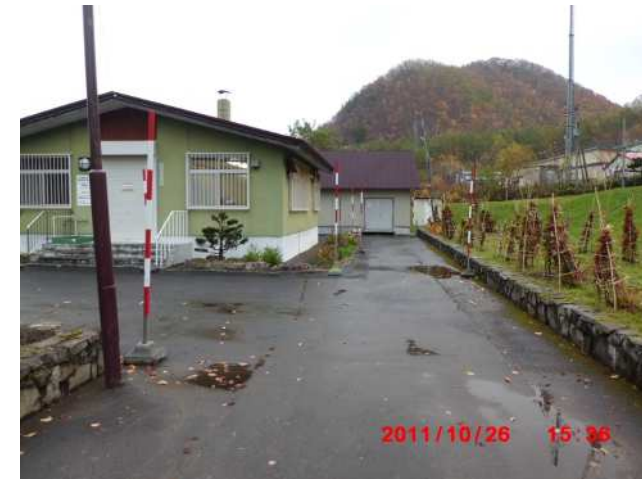
管理事務所正面右から倉庫方向
