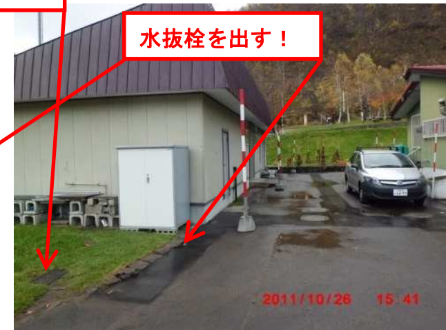
進入路から見たポンプ室兼倉庫
