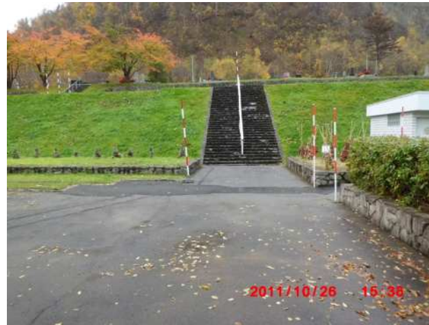
除雪指示していない階段(トイレ側)
