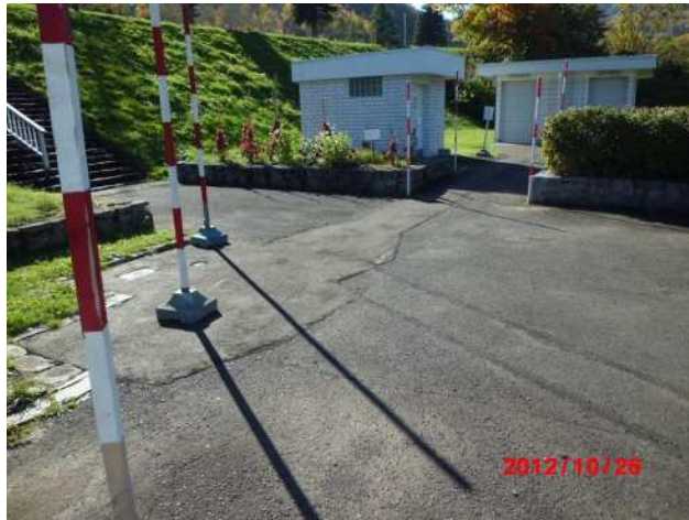
除雪通路中間地点からトイレ方向
