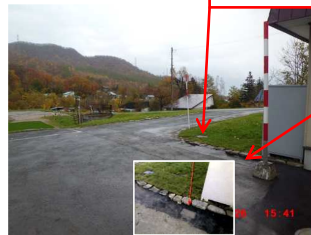
ポンプ室前から見た進入路
