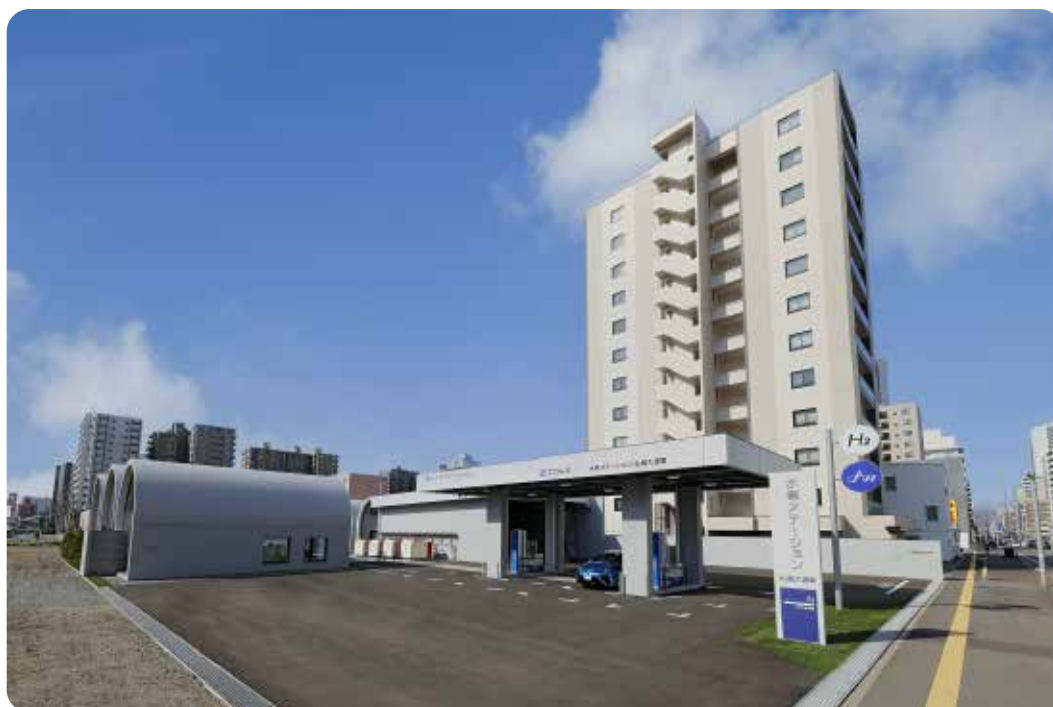
▲水素ステーション札幌大通東
