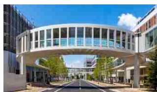
図 2-40 新札幌駅周辺地区Ⅰ街区アクティブリンク（空中歩廊）
