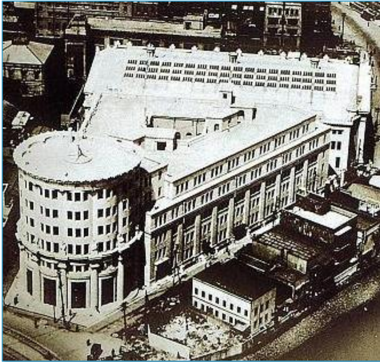
【旧：東京証券取引所ビル（1927・1931年竣工）】
