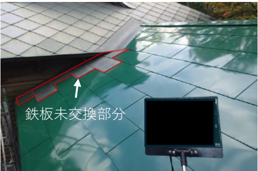
写真2 渡り廊下屋根との取り合い部 （鉄板未交換部分：赤枠内）
