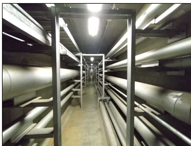
図 2.7 既設共同溝姿（発寒破碎工場側より現発寒清掃工場側を撮影）
