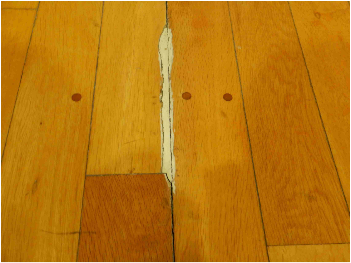
競技室 床張替箇所 参考写真
