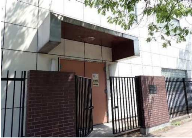
澄川受電所 外観
