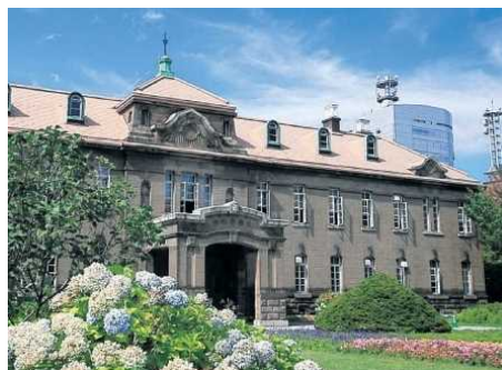
旧札幌控訴院庁舎(重要文化財)
