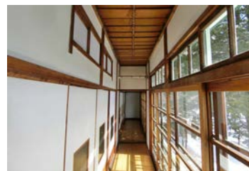
旧三菱鉱業寮の二重窓
