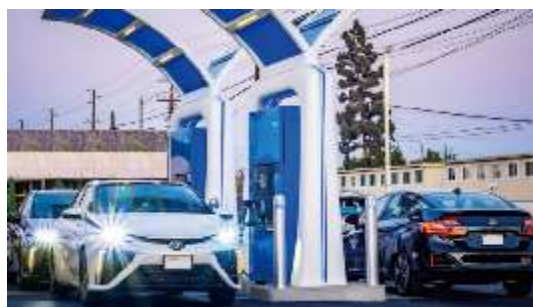
水素ステーション
