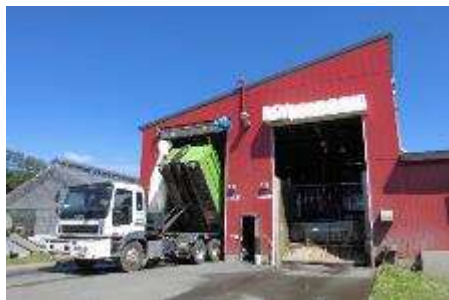
鹿追町バイオガスプラント
