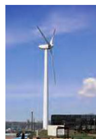
風力発電所の電力からグリーン水素を製造
