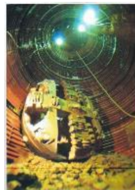
白川第3送水管新設工事 (平成15～令和元年)
