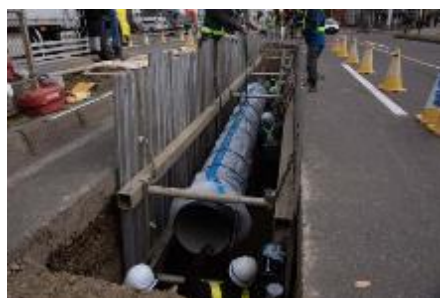
配水管の布設替え
