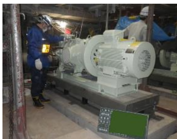
ポンプ設備更新工事
