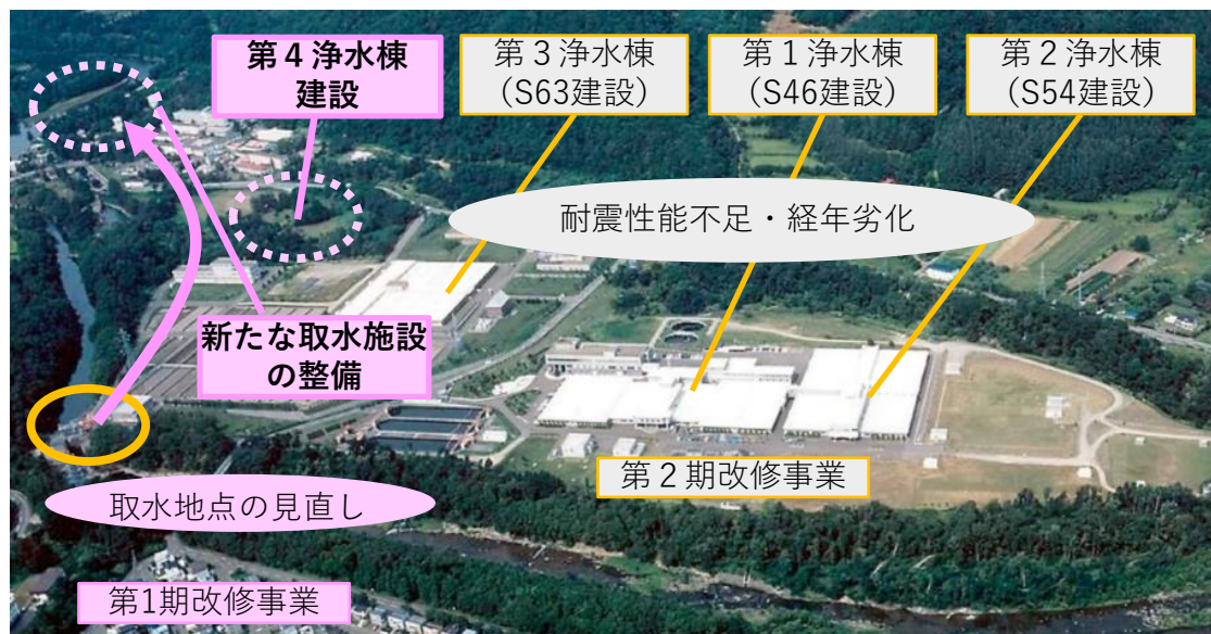
【図表27】白川浄水場の全景
