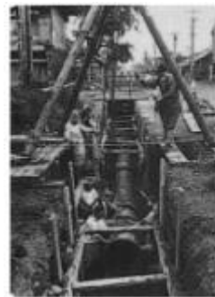
創設期の配水管工事 (主に人の手や馬の力による)
