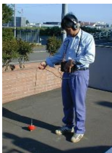
漏水探知機による調査
