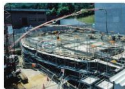
藻岩浄水場改修工事 (平成9～15年)
