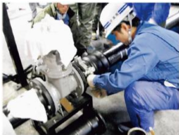
配水管接合実習
