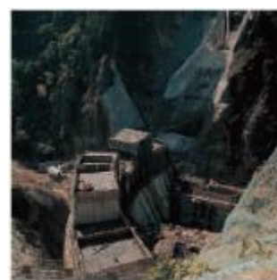
豊平峡ダムの建設
