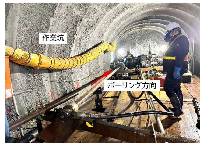
南鶉工区ボーリング削孔状況
