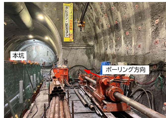
台場山工区ボーリング削孔状況
