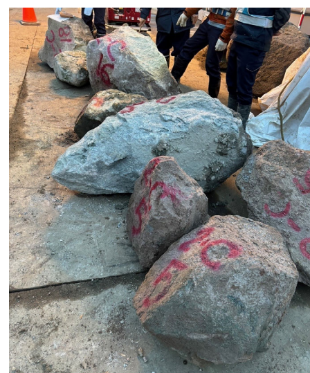
今回撤去した岩塊(長径最大約1.4m)
