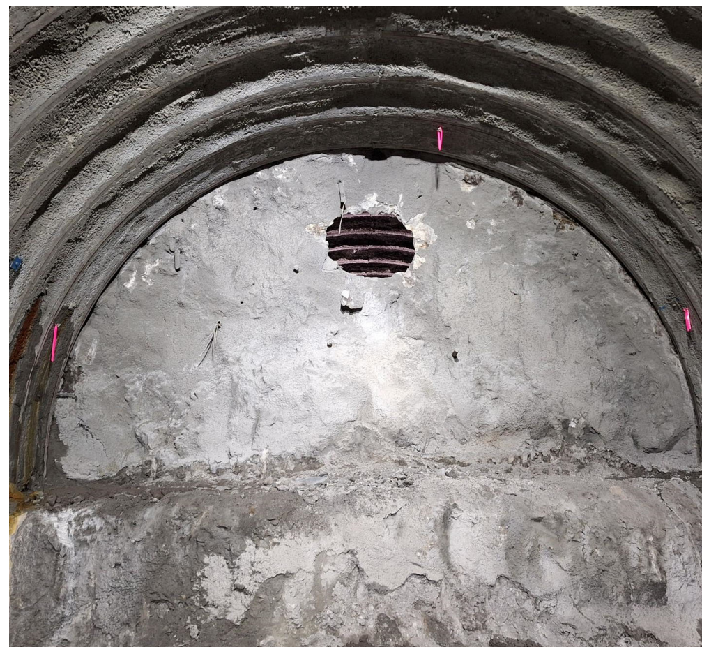
貫通点の状況
