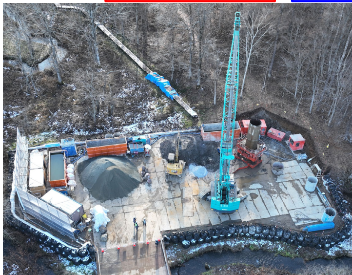
岩塊撤去状況
