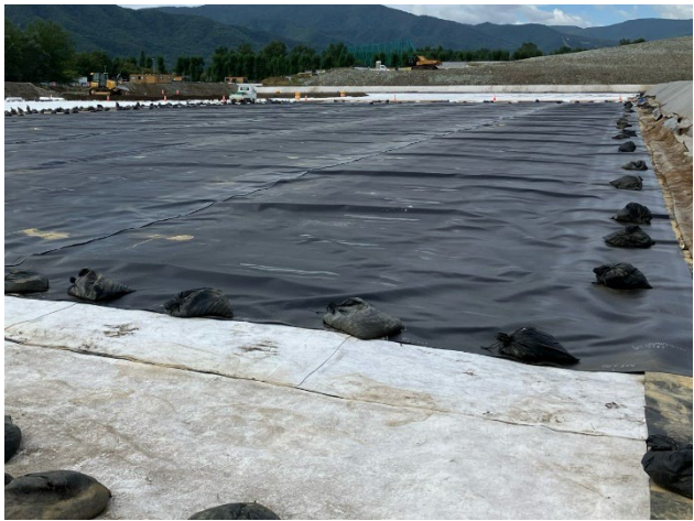
遮水シート施工状況（令和 6 年 11 月）
