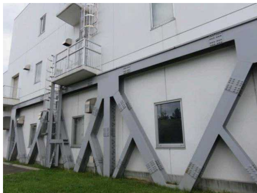
揚水施設の耐震化(外部補強)
