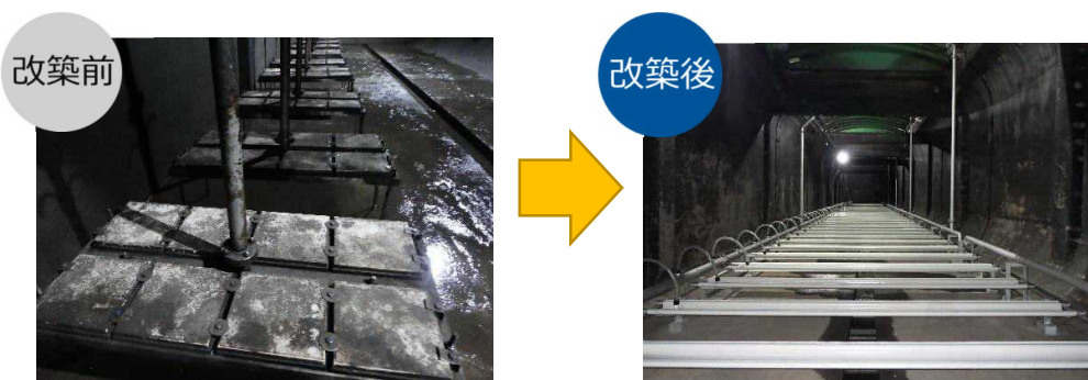
機械設備の改築(散気装置)
