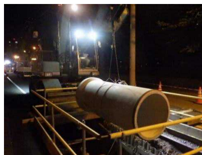
管路の耐震化(管路の入れ替え)
