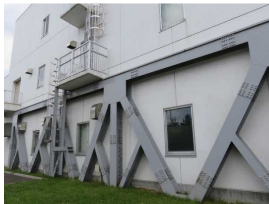
揚水施設の耐震化（外部補強）
