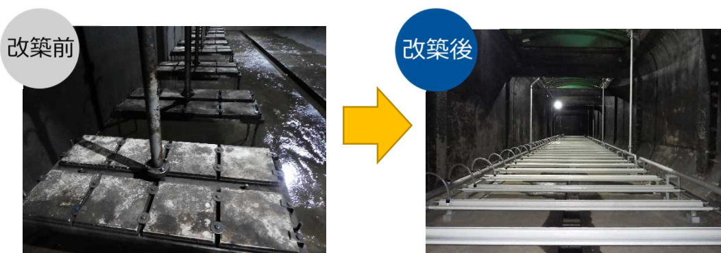
機械設備の改築（散気装置）
