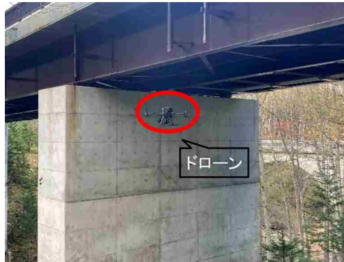
ドローンを使った橋梁の点検
