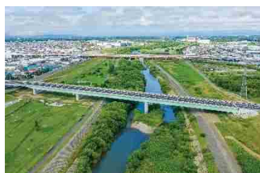
道路・橋梁の整備
