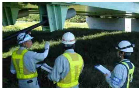
橋梁の緊急点検訓練
