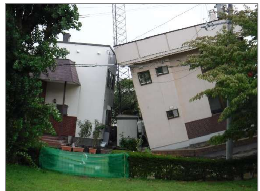
図2-3 札幌市内の被害
