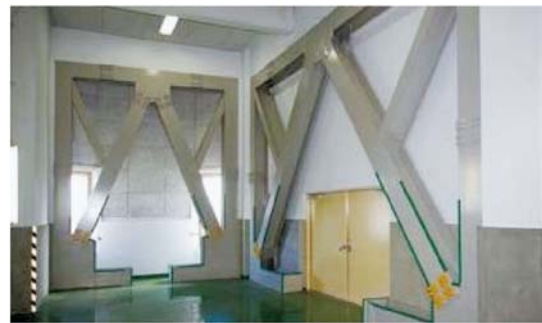
○水再生プラザの耐震補強状況
