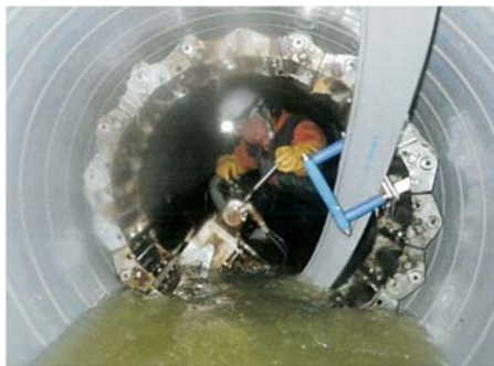
○管路の耐震化工事の様子
